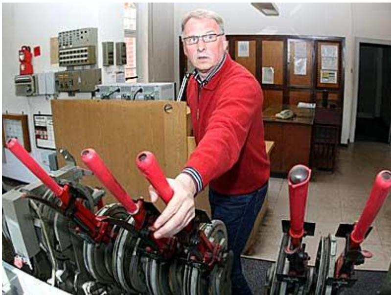
Aber die Tage der handgestellten Weichen sind gezählt. Im Mai 2011 geht das neue elektronische Stellwerk in Euskirchen ans Netz. Dann werden die Signale bis nach Bonn von dort aus betätigt. Der Technikwechsel gleicht einem Sprung aus dem Altertum in die Neuzeit. Die manuelle Technik, wie sie noch heute in den Stellwerken Duisdorf, Witterschlick, Kottenforst, Meckenheim, Rheinbach, Odendorf und Kuchenheim eingesetzt wird, stammt zumeist noch aus den Vorkriegsjahren.
